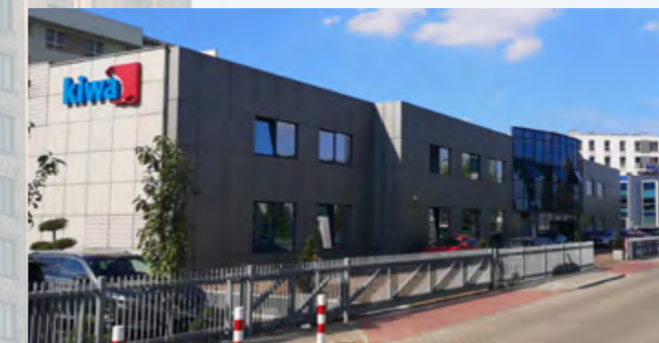
Oficina principal de Kiwa Polonia en Varsovia.
